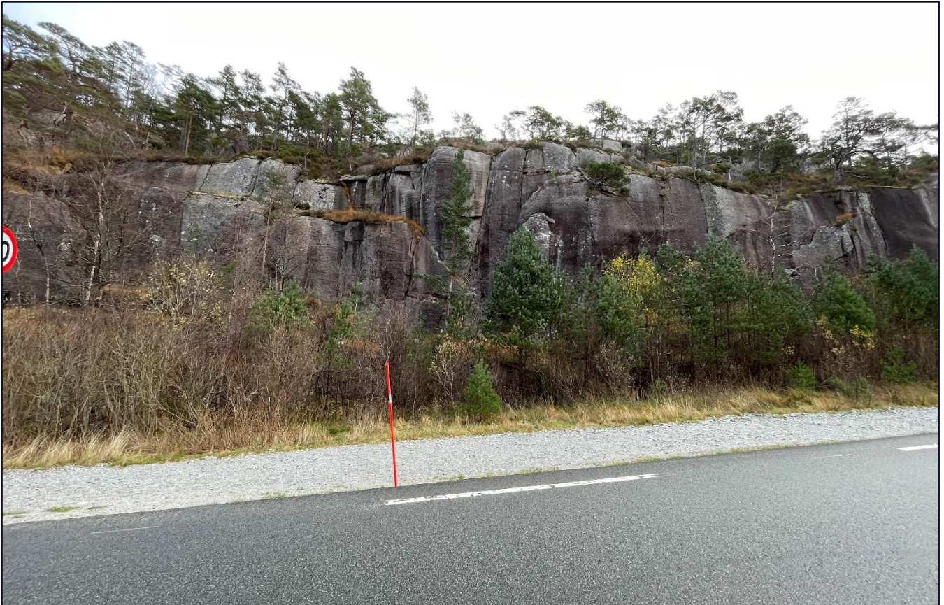
Figur 33 Bilde 11 er tatt mot øst og er et nærbilde av én av de nær vertikale skrentene fjellsiden opp mot Åreskogtjørna består av. Bildet viser videre hvor massiv og lite oppsprukket granitten er i vurderingsområdet. Bilde av Skrið
