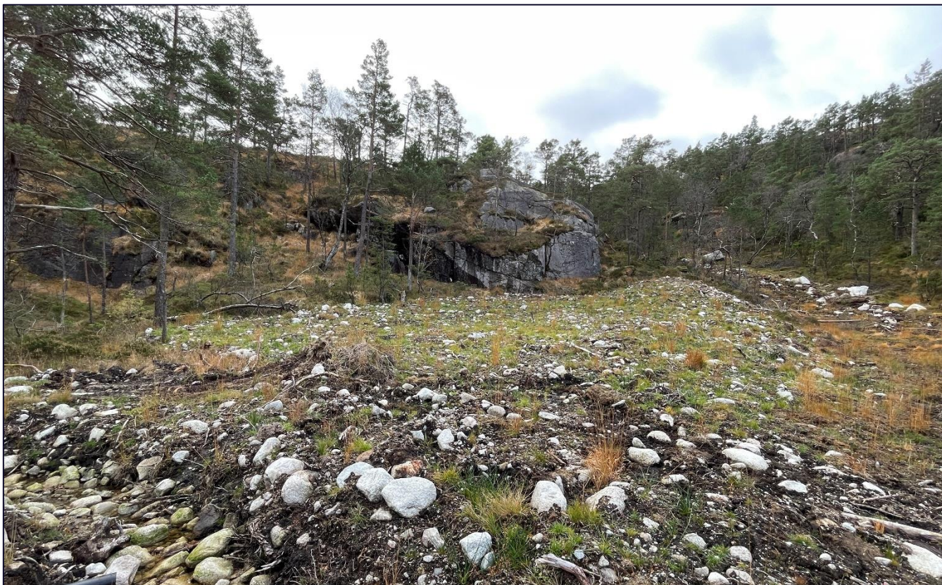
Figur 31 Bilde 9 er tatt nord i tiltaksområdet, i nærheten av hvor det skal anlegges ny tursti. Det er noen skrenter med bart fjell i dagen her, men fjellet fremstår massivt og med lavt løsnepotensiale for steinsprang. Videre er skrentene relativt steile og eventuelle steinsprang fra disse skrentene vil få kort løp da det ikke er akselerasjonsfelt i de flate partiene under skrentene. Bilde av Skrið
