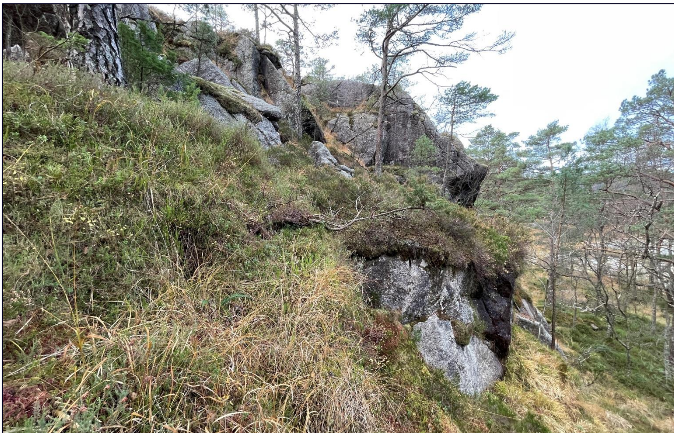
Figur 30 Bilde 8 er tatt nord i tiltaksområdet, i nærheten av hvor det skal anlegges ny tursti. Det er noen skrenter med bart fjell i dagen her, men fjellet fremstår massivt og med lavt løsnepotensiale for steinsprang. Bilde av Skrið
