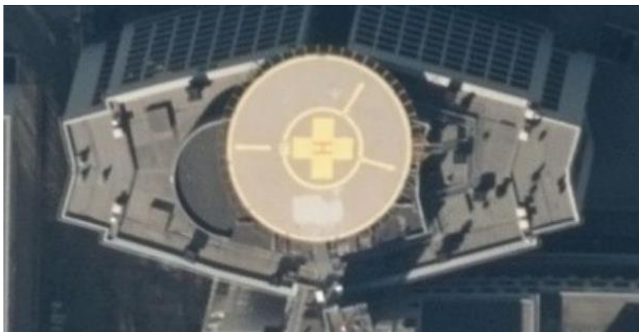
Figur 4 Bodø sykehus - Merking av helikopterlandingsplass (norgebilder.no)
