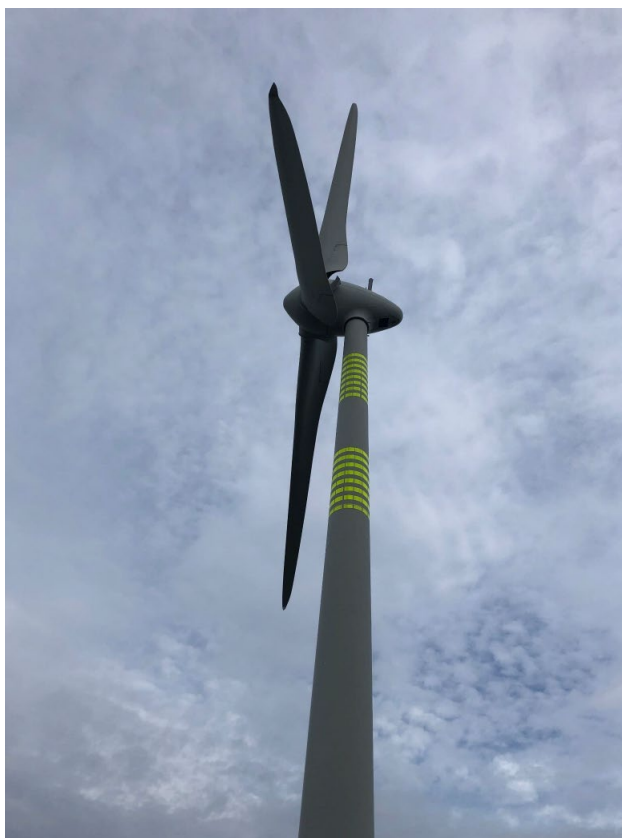
Foto av turbin på Mehuken II med påmontert reflekterende magebelte
