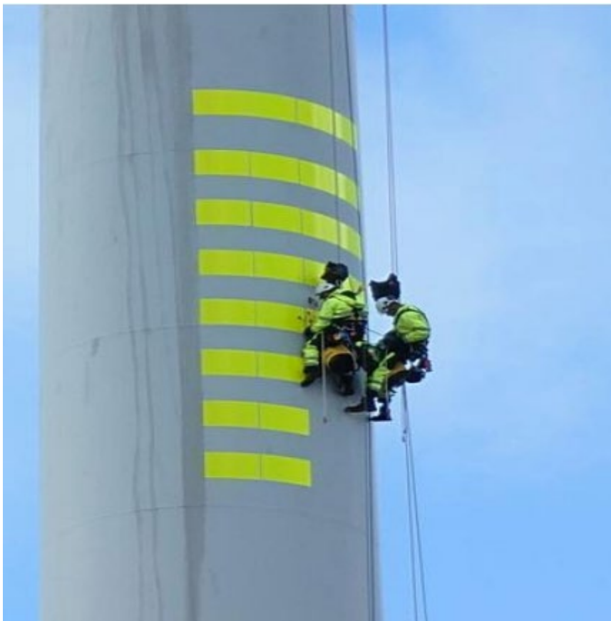
Foto av arbeid med montering av magebelte på Guleslettene
